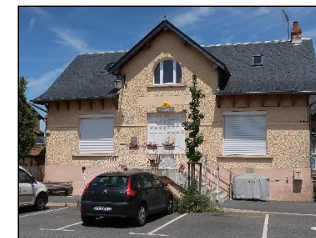
Poste d'Alrance Source : Artifex 2019
