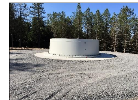
Fondation remblayée Source : Artifex 2018
