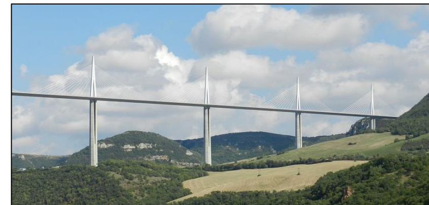
Viaduc de Millau
