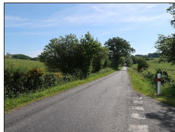
Route départementale D522 Source : Artifex 2019
