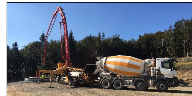
Coulage du béton Source : Artifex 2018
