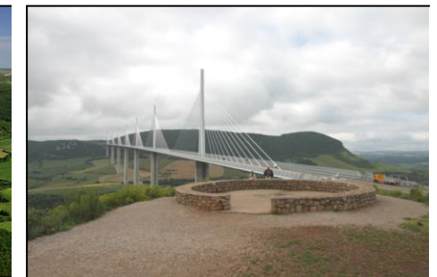
Le Viaduc de Millau Source : Artifex 2016
