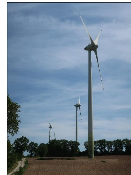
Parc éolien de Lestrade-et-Thouels Source : Artifex 2019
