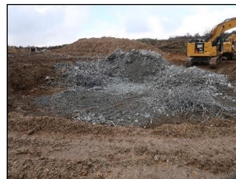
Démolition d'une fondation Source : Artifex 2018
