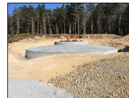
Fondation non remblayée Source : Artifex 2018
